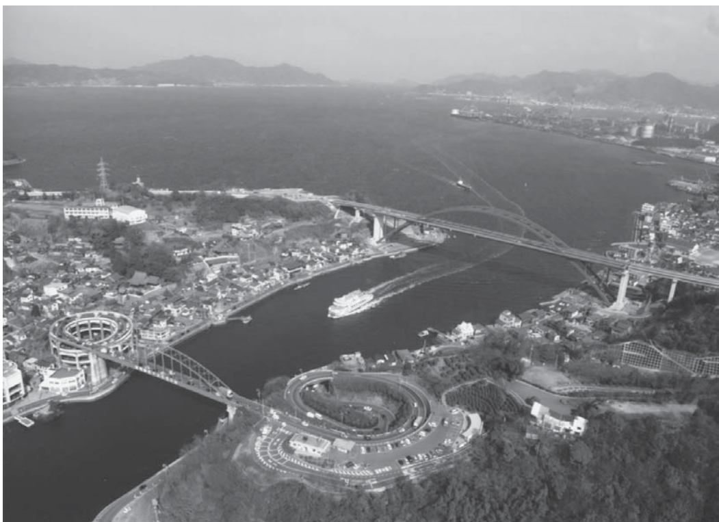
完成した第二音戸大橋
